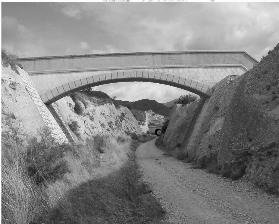
ABAJO: Paso elevado zona de Agost construido para ser usado como acueducto en una de las primeras curvas de este trazado ferroviario. Al fondo, se divisa uno de los primeros túneles de la línea Agost-Alcoy / FRANCISCO JOSÉ ANTÓN
