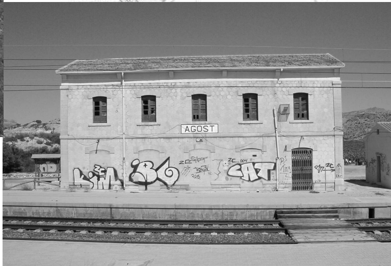
Estación de Agost. Línea Madrid-Alicante. P.K. 438,959. Actualmente, la vía verde Agost-Alcoy se inicia en este punto a la izquierda de la fotografía. / FRANCISCO JOSÉ ANTÓN
