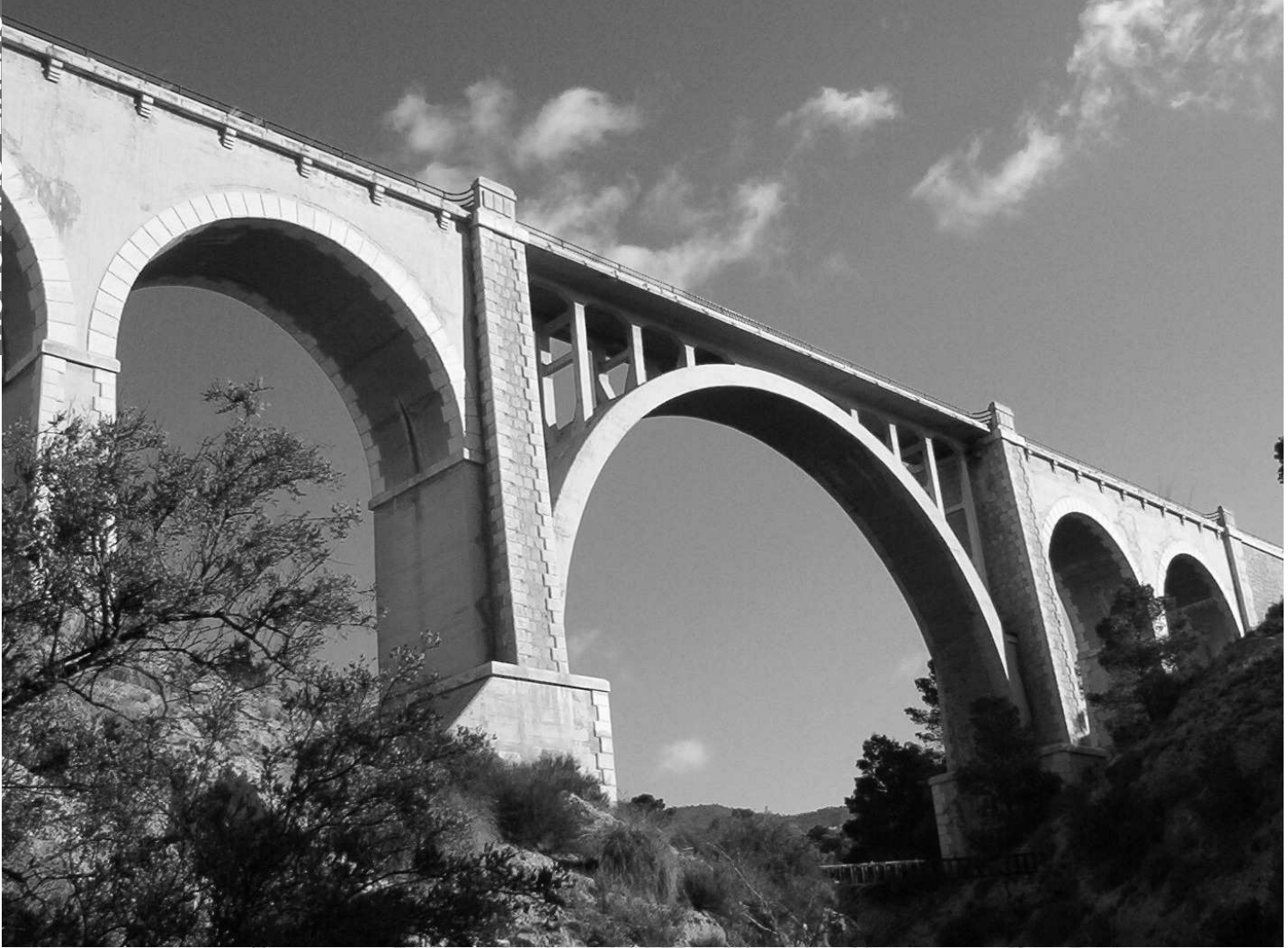
ARRIBA: Viaducto de Fontanás. Otro de los impresionantes puentes que existen en la línea Agost-Alcoy / FRANCISCO JOSÉ ANTÓN ABAJO: Boca de túnel en el puente del Vidre. Situado antes de cruzar por el último túnel que atraviesa esta vía inconclusa (el sexto desde Agost). A partir de aquí, la línea se aleja de la montaña en dirección a Agost. / FRANCISCO JOSÉ ANTÓN
