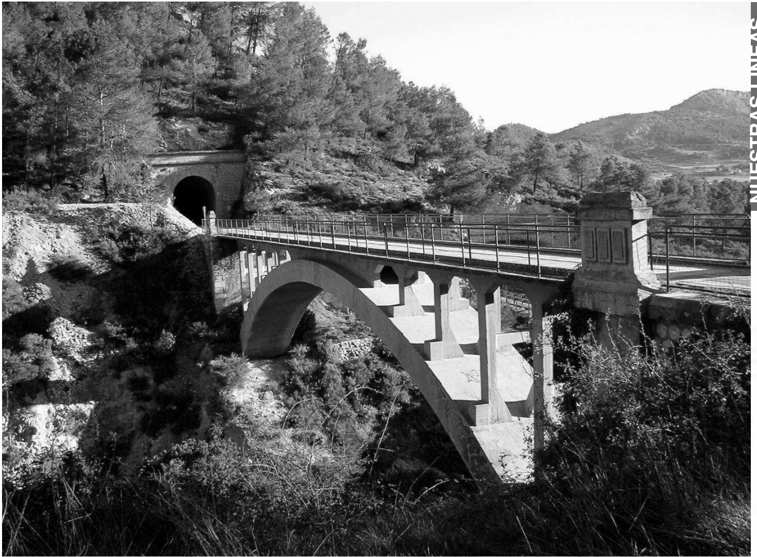
ARRIBA: El Pont de Sant Antoni salva el pequeño barranco que corta dos larguísimos túneles y que discurre paralelo a la carretera nacional N-340 / FRANCISCO JOSÉ ANTÓN ABAJO: Salida del cuarto túnel de Agost. Este túnel no atraviesa roca sino una ladera arcillosa que se deposita en las paredes que le da un tono rojizo. Se trata de uno de los túneles más largos de este ferrocarril. Se puede recorrer a pie pero es necesario estar provisto de una buena linterna. / FRANCISCO JOSÉ ANTÓN
